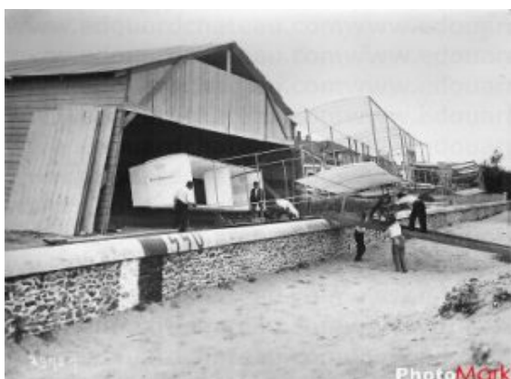
La sortie des hangars
