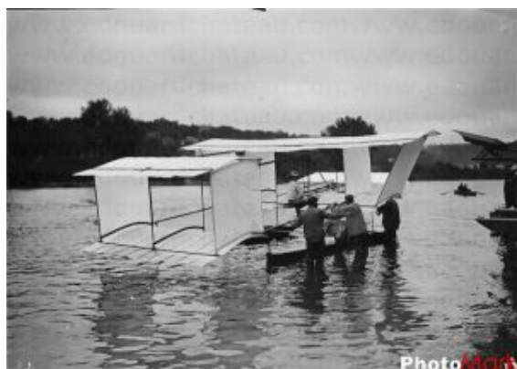
Essai sur l'eau
