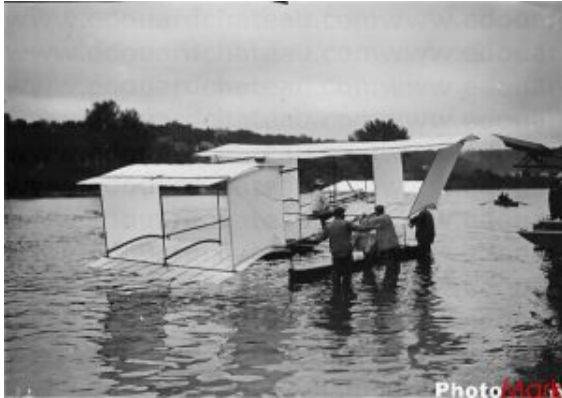
Essai sur l'eau
